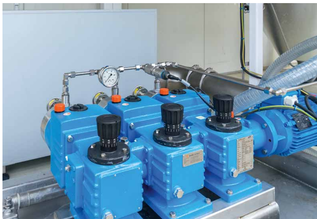
De hogedrukpomp die de voeding met hogedruknozzles verspreit.
