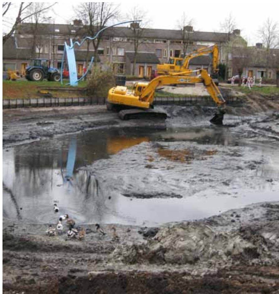
De vijver De Ploeg tijdens het baggeren.
