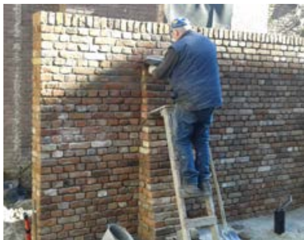
Opmetselen oude muur ten behoeve van muurvegetatie.
