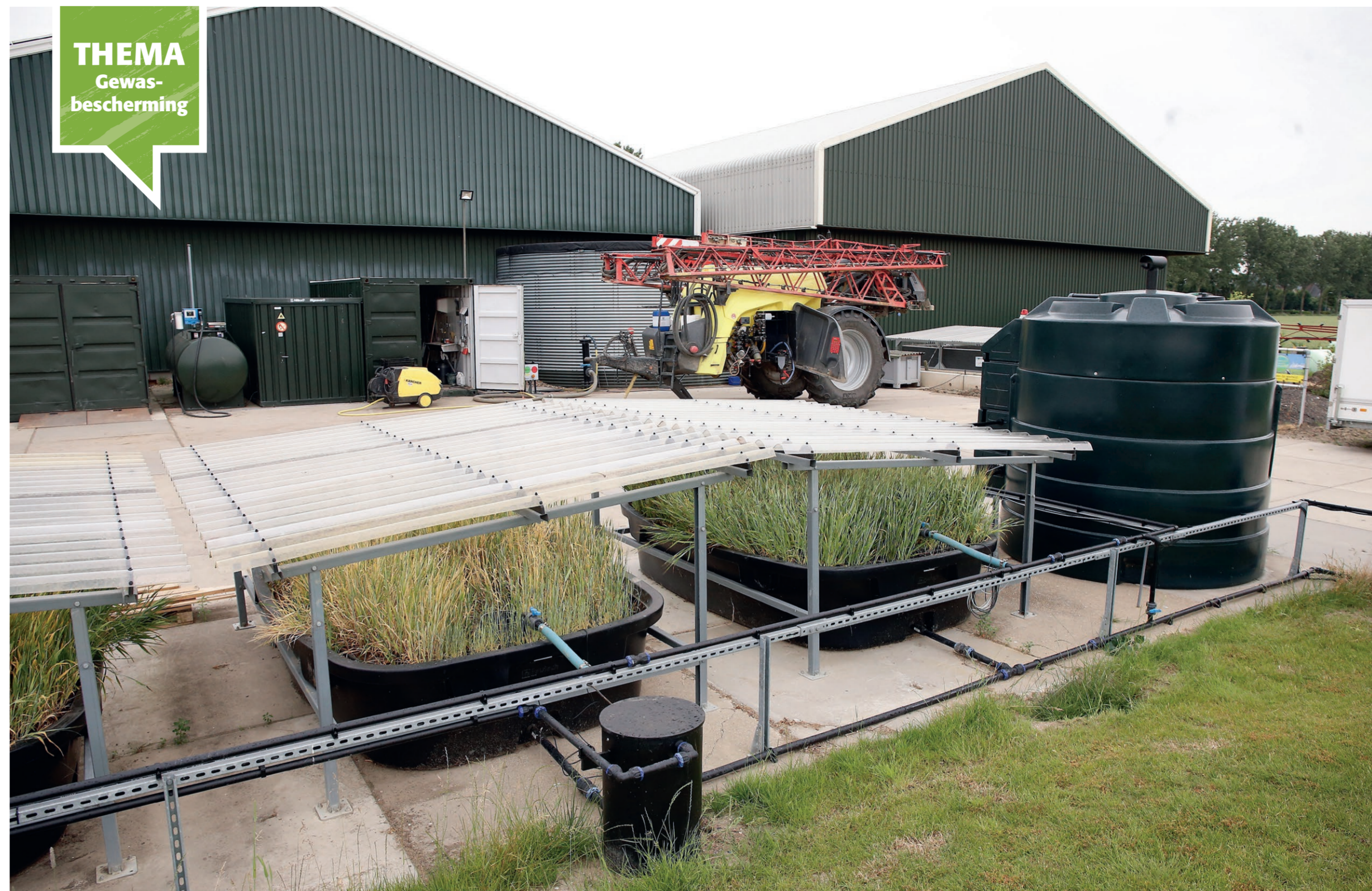
Een moderne wasplaats met opvang voor restvloeistoffen kan de erfemissie fors beperken, maar het vergt wel een flinke investering.
