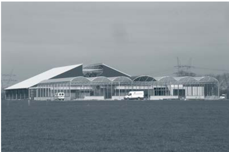
Het foliedak van het voormalige melkveebedrijf op de Waiboerhoeve.
