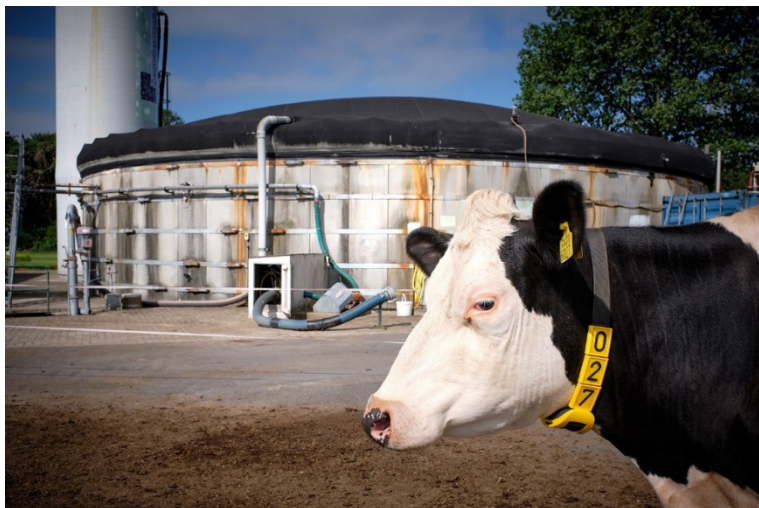
Bovengrondse mestsilo met afdekking.
