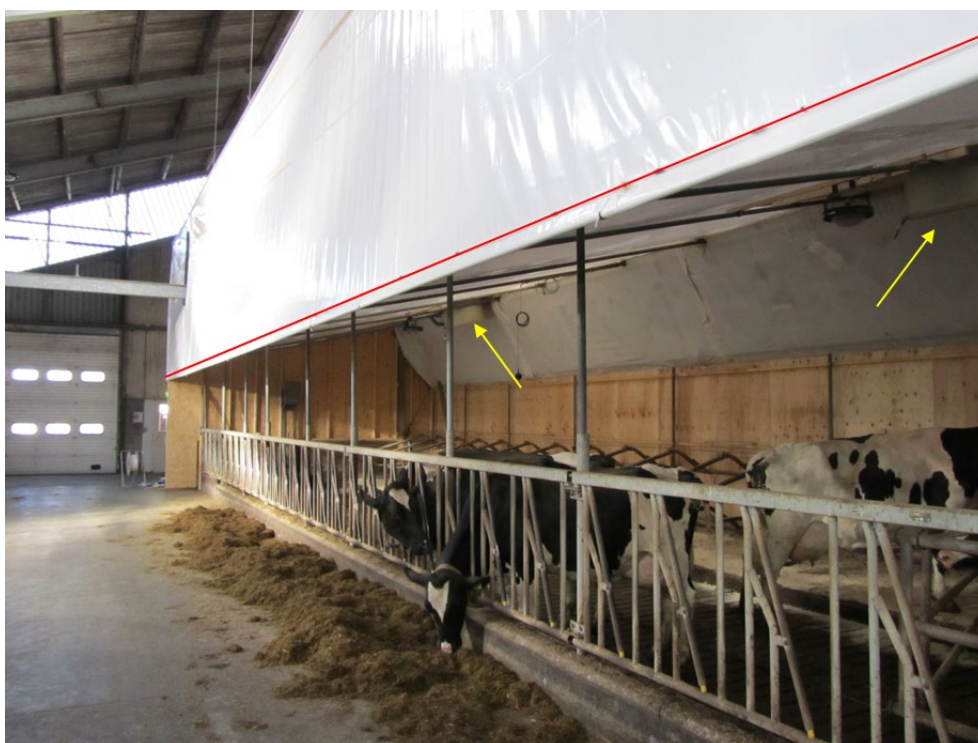
Figuur 3 Zicht op afdeling 16. Het gordijn voor regeling van de luchtinlaat is omhoog. Aan de onderzijde van het gordijn zijn de meetpunten voor meting van de achtergrondconcentratie bevestigd (rode lijn). In de afdelingen zijn de twee ventilatoren voor de luchtafvoer te zien (gele pijlen) waarin zich ook de monsterpunten voor de meting van de ammoniakconcentratie in de uitgaande lucht bevinden.
