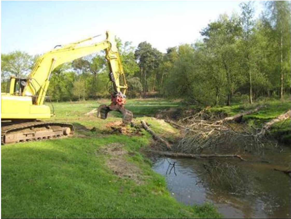
Voorbeeld: Het inbrengen van dood hout in de Tungelroyse beek
