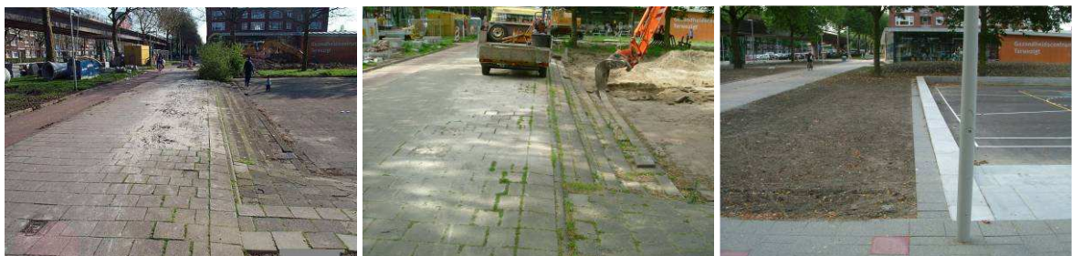
Figuur 1. Voorbeeld van preventieve onkruidbestrijding door verwijdering van onnodig brede en verzakte bestrating (Foto's: Roteb, Rotterdam).
