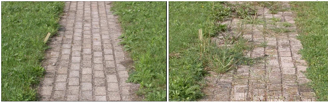
Figuur 5. Voorbeeld van klinkers met voegvulling (links) en klinkers met een standaard brekerzand voegvulling (rechts), twee jaar na aanleg (Foto's: Plant Research International)
