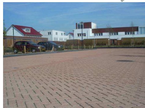
Figuur 2. Voorbeeld van verharding met een waterdoorlatende functie middels een lavapakket onder de verharding (Foto: Plant Research International)
