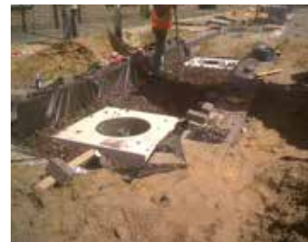
Aanleg verharding met waterbergend en -zuiverend vermogen, Oss 2011
