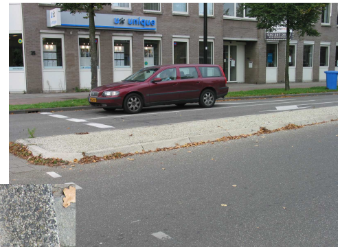
Links: elementverharding met voegvulling
