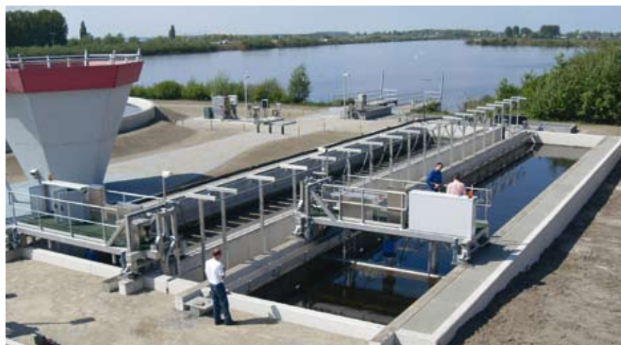
Het Automatic Back Wash Filter (ABWF) in Harderwijk.
